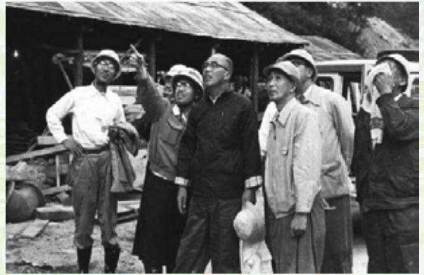
太田垣社長の大町トンネル現場視察
